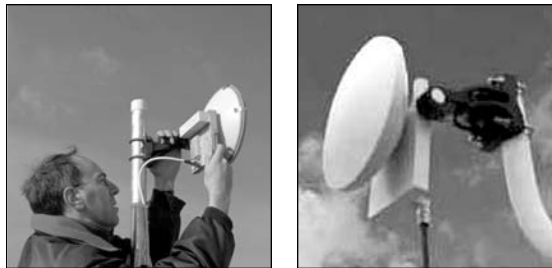
Figura 3.15 Ejemplos de terminales de sistemas de acceso fijo inalámbrico
